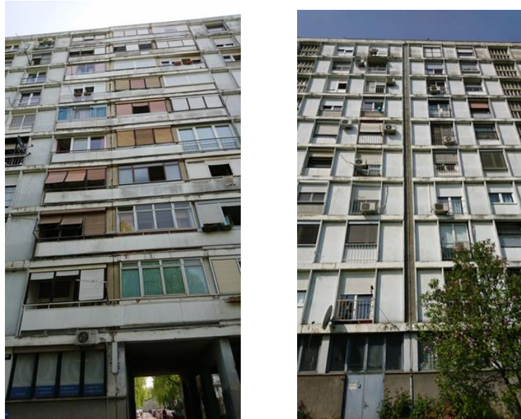
Slika 4.23. Pogled na razdjelnicu s prednje i stražnje strane zgrade
