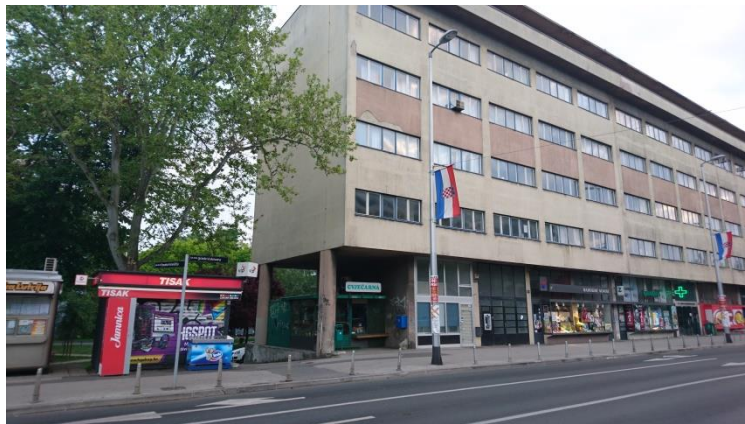
Slika 4.15. Pogled na rubne stupove zgrade
