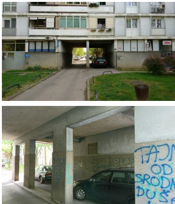
Slika 4.21. Prolaz za automobile kroz središnju dilataciju
