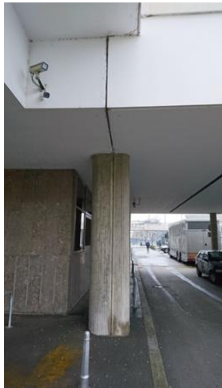
Slika 4.9. Pogled na spoj dviju zgrada
