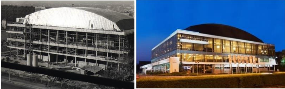
Slika 4.6 Koncertna dvorana Vatroslava Lisinskog u izgradnji i danas [25]
