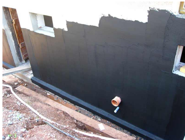
Slika 3.6. Bitumenska ljepenka na mjestu razdjelnice
