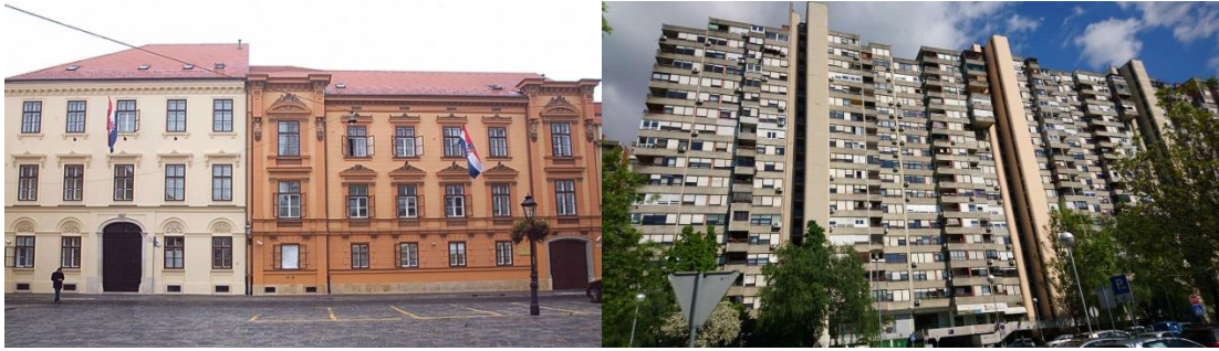
Slika 3.5. Primjeri zidanih i AB zgrada s razdjelnicama - Ustavni sud RH i Mamutica
