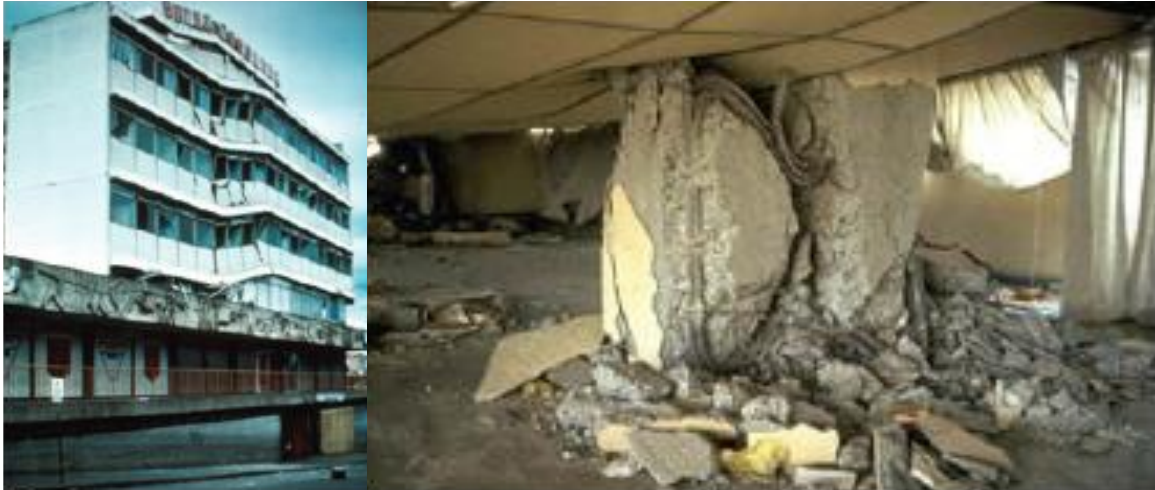
Slika 3.3. Primjer razarajućeg efekta torzije [12]
