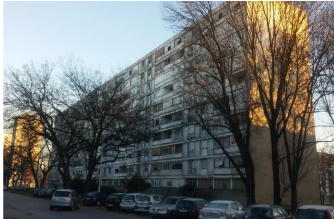
Slika 4.20. Stambena građevina Siget 16 A-F – pročelje JZ
