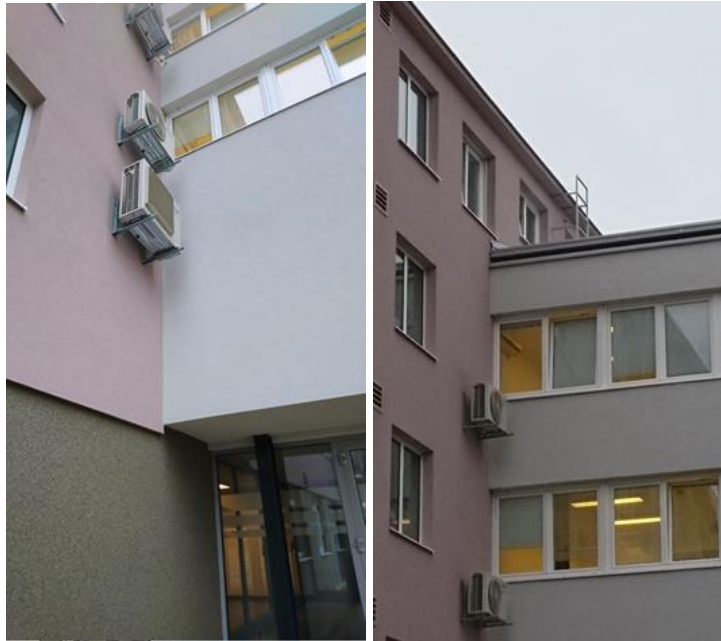
Slika 4.14. Pogled na dilataciju između krila
