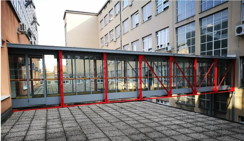
Slika 9.1. Pogled na most Građevinskog fakulteta
