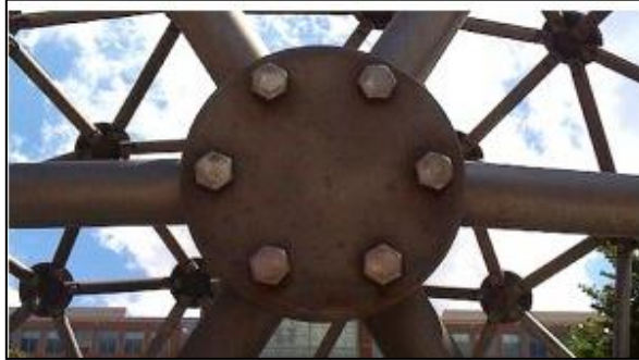
Slika 1.39 Američki način povezivanja cijevi [10]
