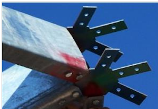
Slika 1.41 Zračni čvor [10]
