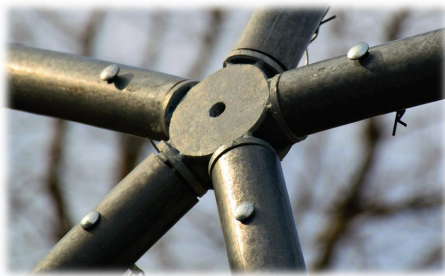
Slika 1.16 Spoj cijevi (čvor) čelične kupole [9]
