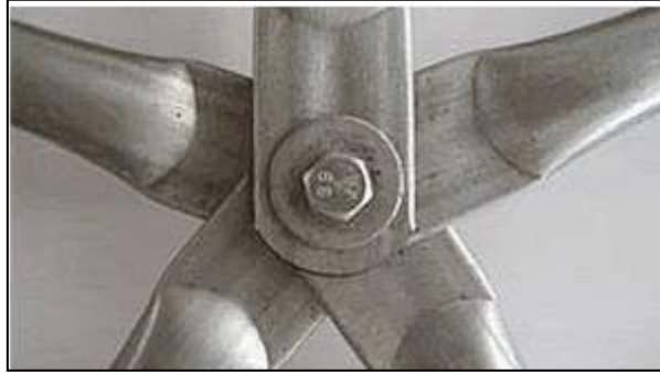
Slika 1.35 Spajanje cijevi na preklop s jednim vijkom [10]
