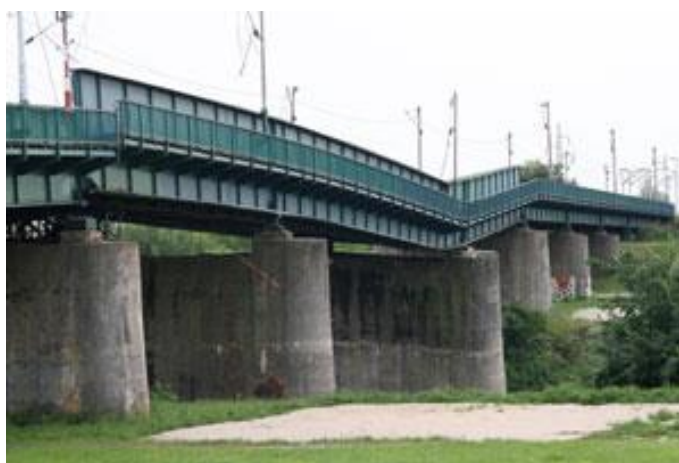
Slika 2. Slom središnjega raspona mosta Sava – Jakuševac
