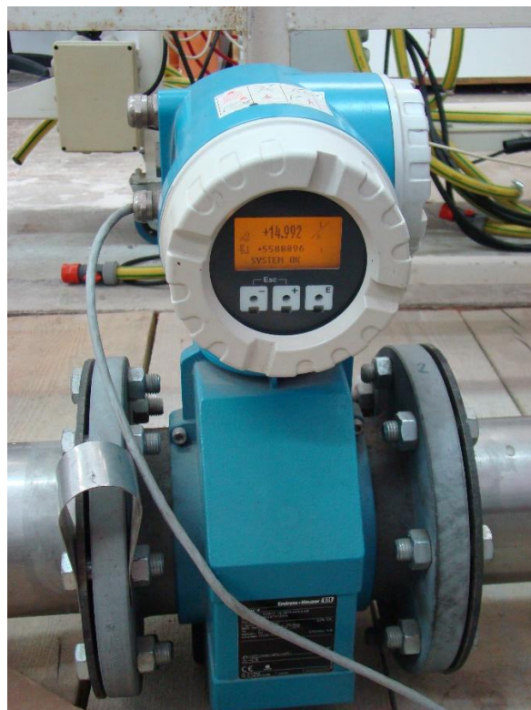
Slika 32. Elektromagnetni mjerač protoka
