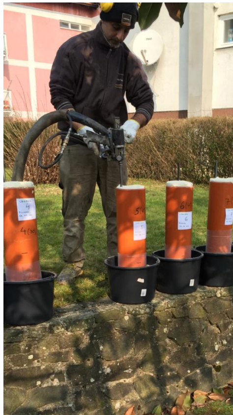
Slika 3.16. Injektiranje ekspandirajuće smole pomoću injekcijskog pištolja
