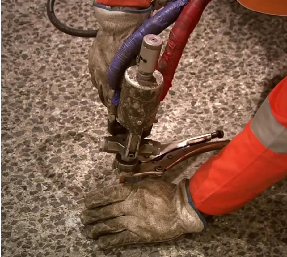
Slika 1.11. Prikaz injektiranja tekuće mješavine
