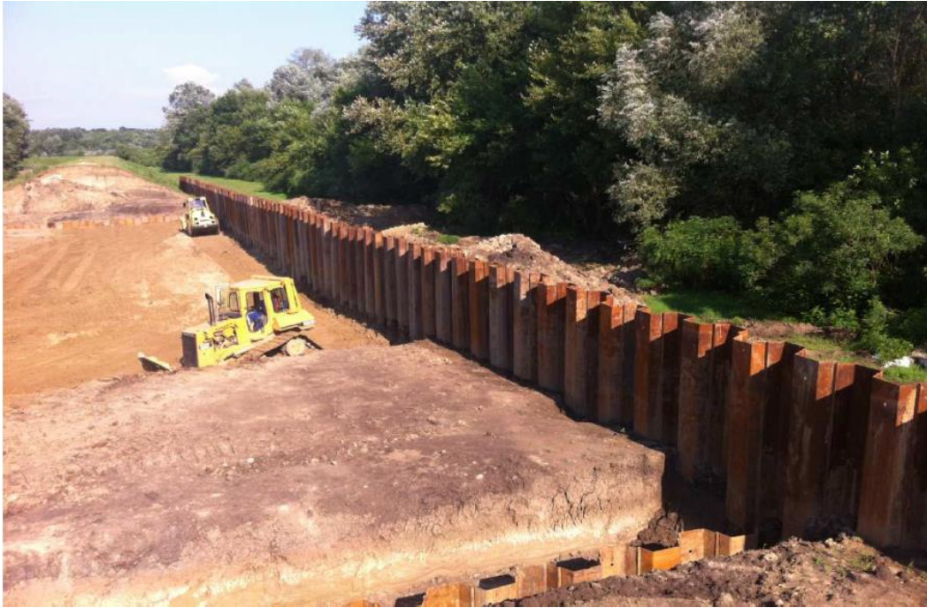
Slika 1.6. Metalne talpe kod nasipa u Račinovcima [5]
