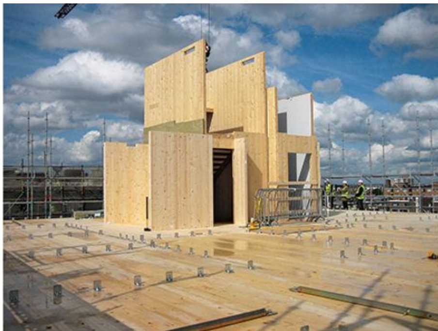
Slika 3.9 Primjeri ugradnje CLT panela
