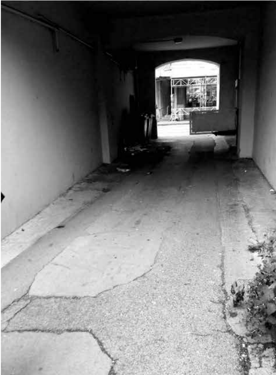
POGLED NA ULAZ S ILICE
