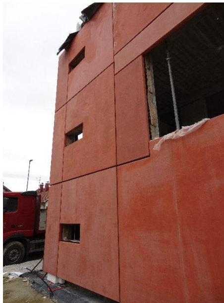
Slika 22. Ugradnja ventilirane fasade s otvorenim fugama
