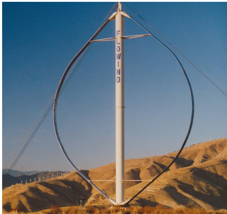
Slika 5: Primjer vjetroturbine s Darrieusovim rotorom [1]
