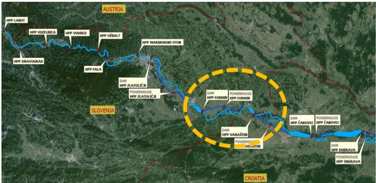
Slika 1. Slijed hidroelektrana na rijeci Dravi u Austriji, Sloveniji i Hrvatskoj.
