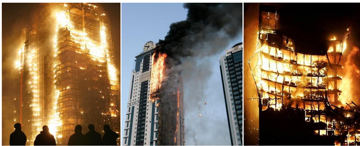
Slika 1.1. Razorno djelovanje požara na čelične konstrukcije
