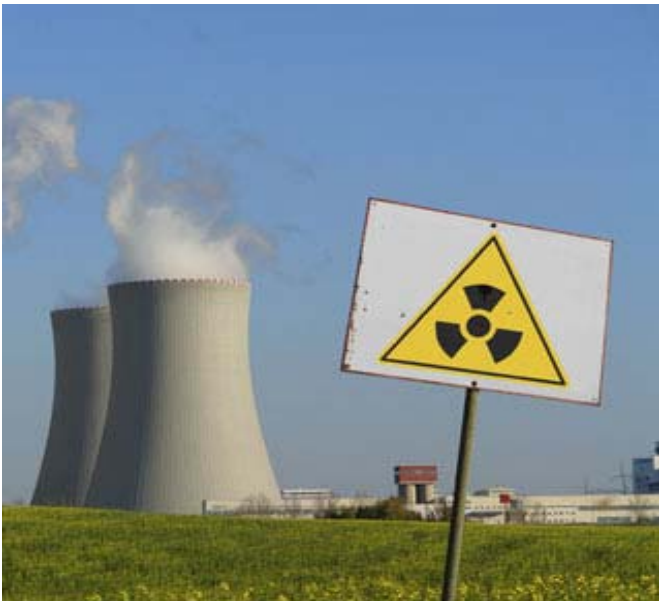
SI.4.:1 Tornjevi nuklearne elektrane
