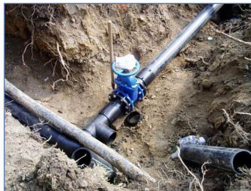
Slika 19 Primjer sekcijskog zasuna vodoopskrbne mreže Kutina - Popovača
