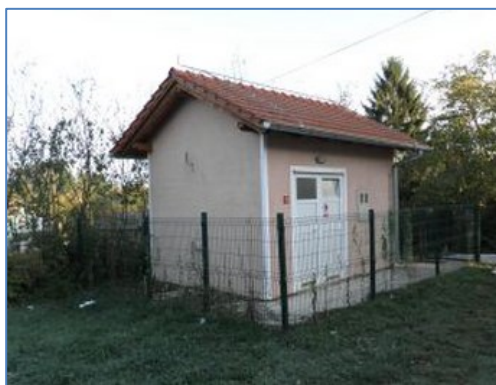
Slika 33 Crpna stanica Husain
