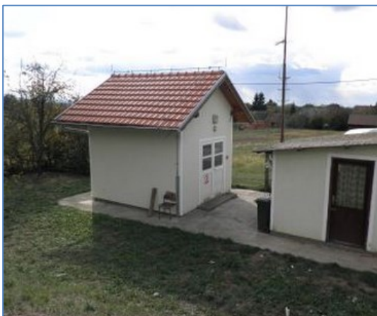
Slika 25 Crpna stanica Visoka zona
