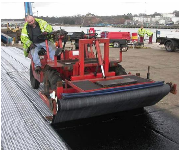
Slika 17. Strojno postavljanje geomreže [12]
