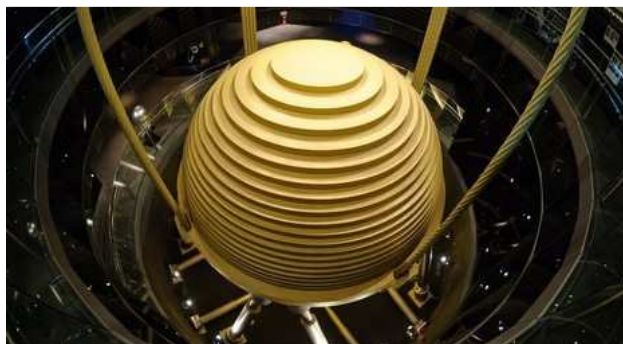
Slika 3.5. Prigušivač s usklađenom masom (Taipei 101)
