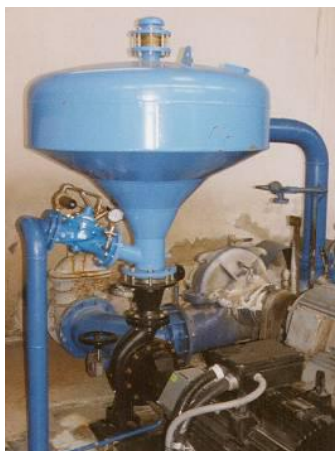
Slika 33. Hidraulička dioda stožastog oblika koja se uspješno koristi za zaštitu od vodnog udara [15]
