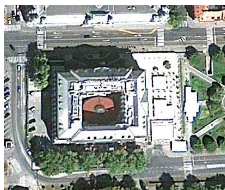
Slika 3.1.2. Pogled odozgo: hotel Esplanade (sjever je prema gore).
