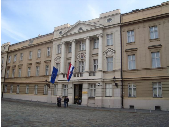
Slika 3.7.1. Zgrada Hrvatskog sabora.
