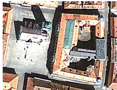
Slika 3.7.2. Prikaz odozgo: zgrada Hrvatskog sabora (sjever je prema gore).
