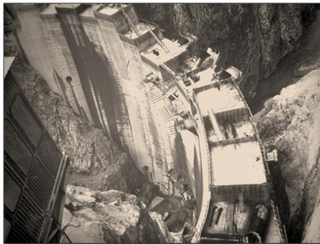
Slika 11.1.: Gradnja HE kao primjer važnosti primjene podataka o tijeku topline hidratacije [21]
