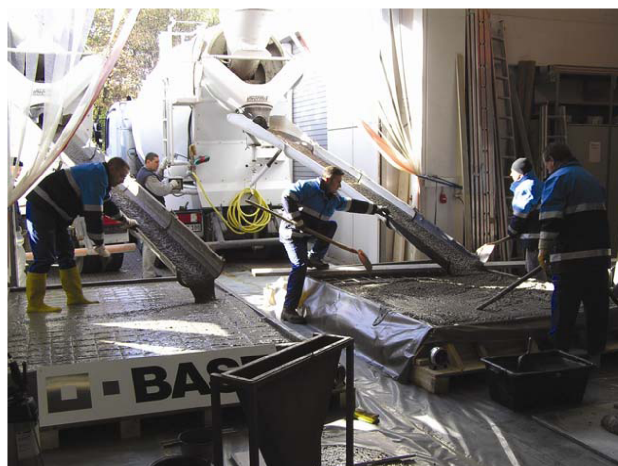
Slika 18. Usporedno betoniranje običnog i betona s dodatkom VMA
