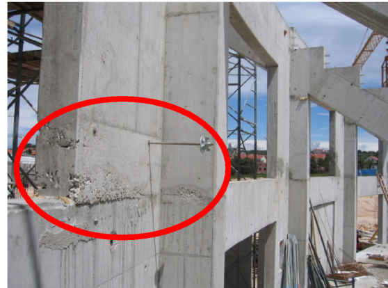
b) pojava oslabljenja konstrukcije zbog lošeg izvođenja vibriranja na mjestima spoja oplata s postojećom konstrukcijom
