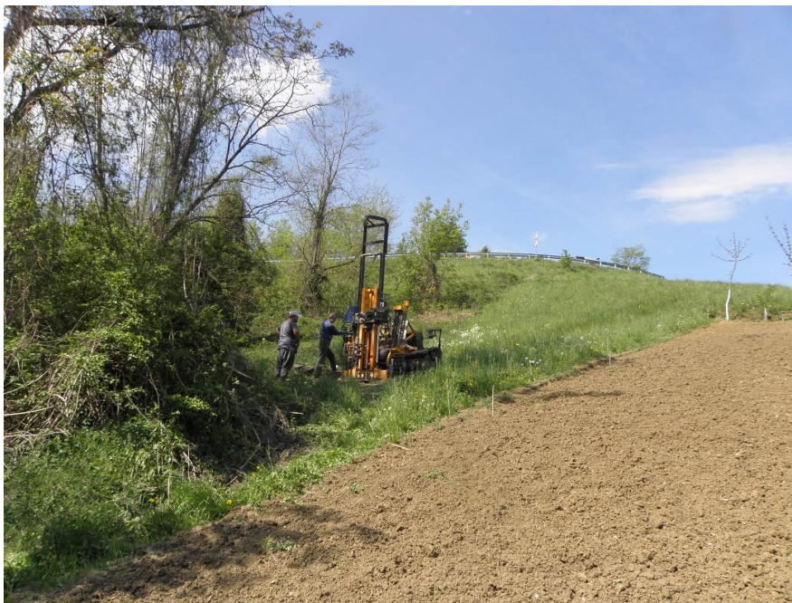
Slika 22: Prikaz istražnog bušenja na poziciji istražne bušotine B6
