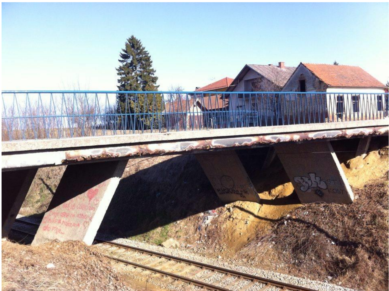
Slika 36.2. Erozijska nasipa
