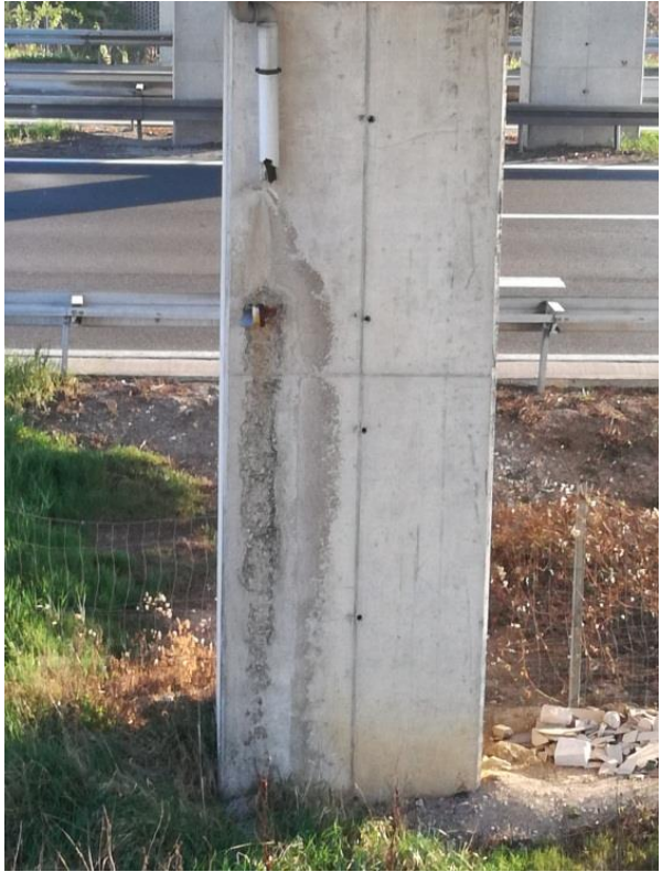
Slika 57. Vlaženje i odlamanje zaštitnog sloja stupa
