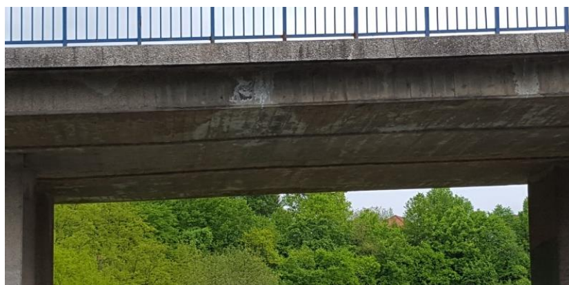
Slika 15. Iscvjetavanje ploče
