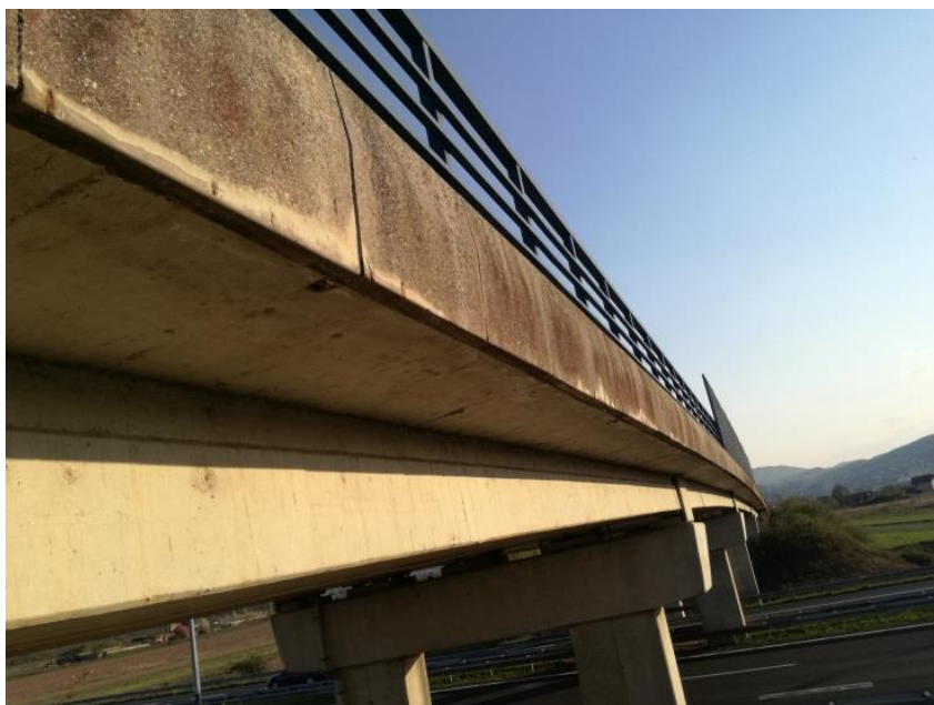
Slika 56. Vlaženje vijenca
