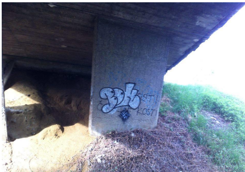
Slika 36.1. Erozija nasipa
