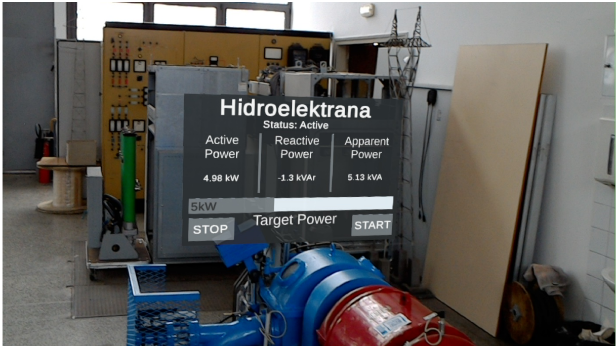
Slika 20. Hologram s upravljačkim grafičkim sučeljem za hidroelektranu
