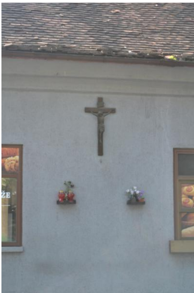
Slika 43. Raspelo na pročelju u Ulici Sveti Duh
