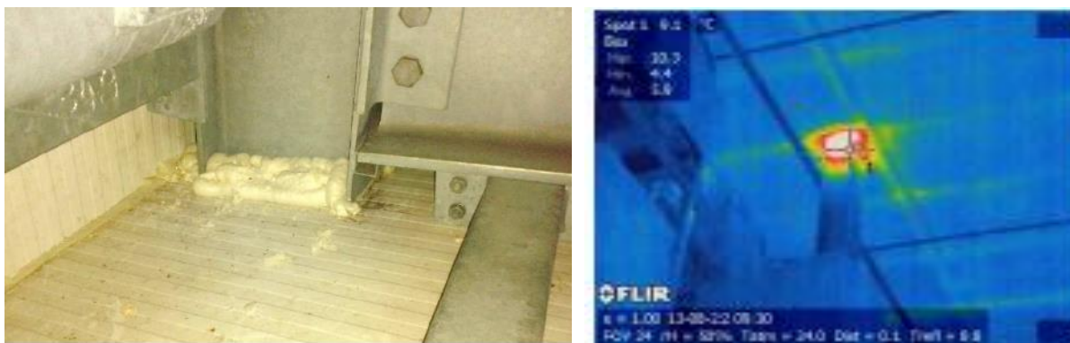
Slika 6-6 Konstruktivni toplinski mostovi [2]
