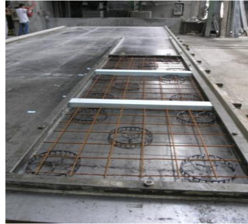
d) postavljanje oplata i armature za vanjski sloj
