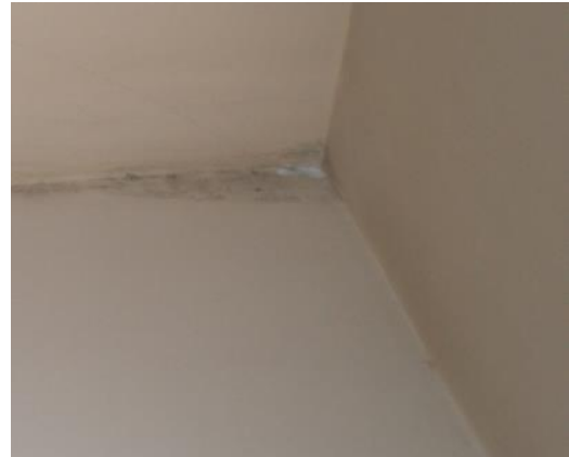
Slika 6-3 Geometrijski toplinski most [2]
