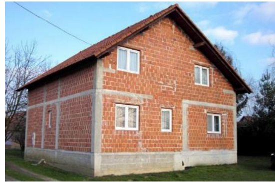
Slika 6-4 Geometrijski toplinski mostovi [2]
