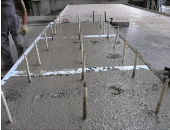
c) betoniranje nosivog sloja
