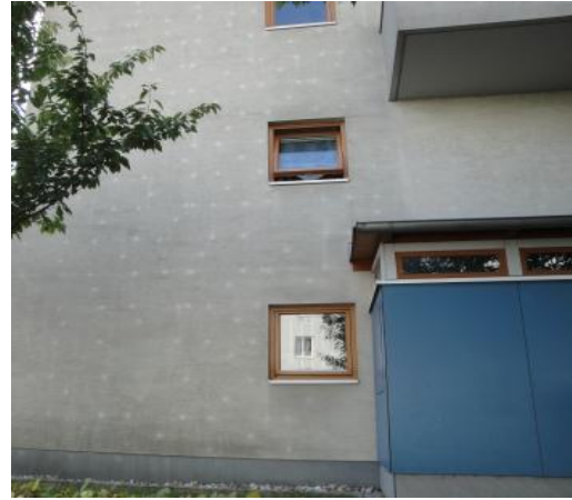
Slika 6-2 Primjer točkastog toplinskog mosta [27]
