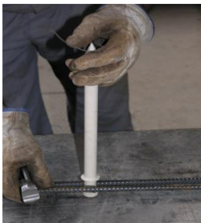
a) vezanje polimernih kompozitnih spona za armaturu
