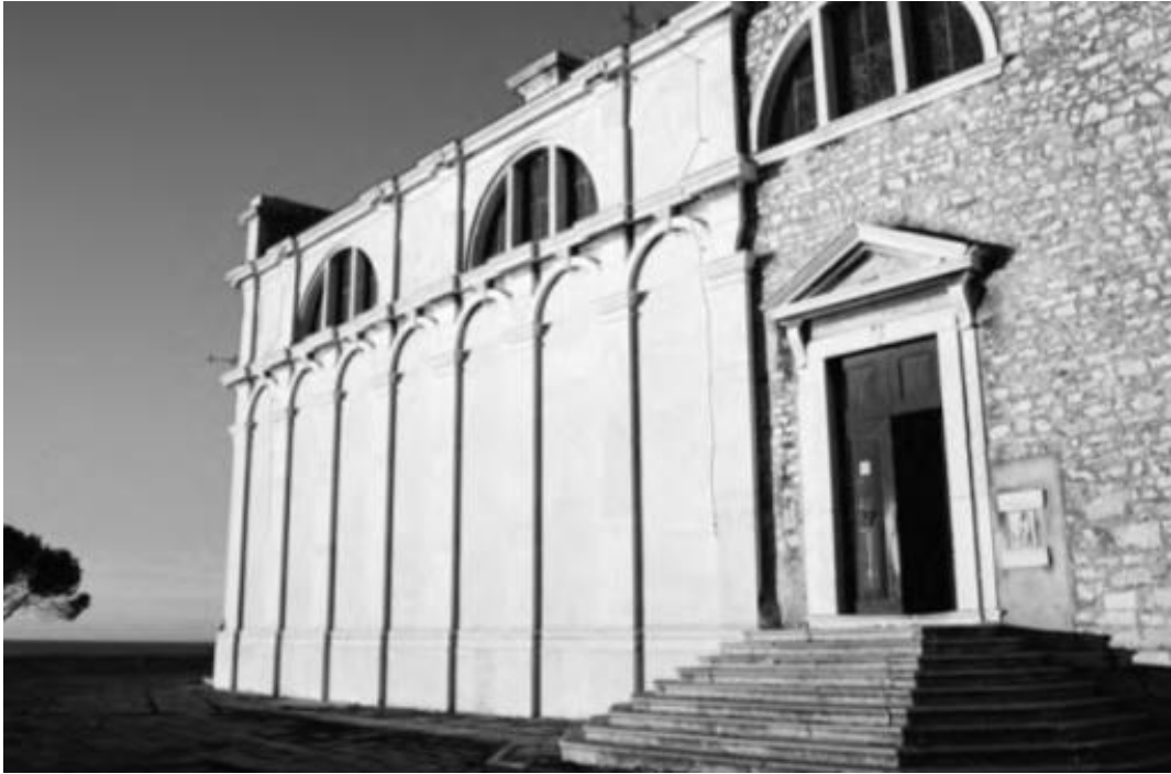
Slika 42: Crkva sv. Eufemije, Rovinj, bočno pročelje
