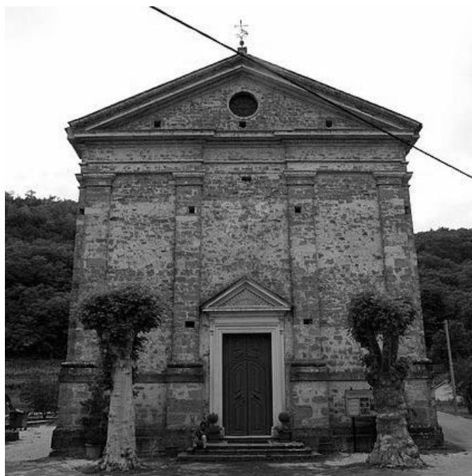
Slika 36: Crkva Rođenja Blažene Djevice Marije, Završje, pročelje
