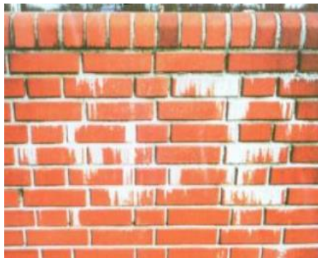
Slika 6. Izluživanje vapna [12]
