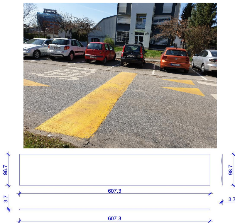
Slika 74. Poprečna betonska umjetna izbočina u Ulici Pile IV.
