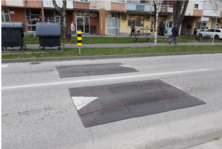
Slika 18. Trapezna gumena uzdignuta ploha u Ulici Dragutina Golika
