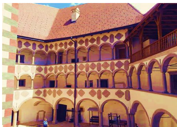
Slika 12. Unutrašnjost dvorca - pogled na lukove, stupove i zatege
