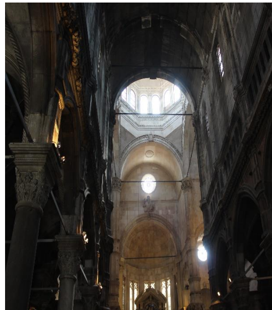
Slika 7. Sustavi zatega : Peristil (Split), Knežev dvor (Dubrovnik), Veliki Tabor(Hum Košnički), katedrala sv. Jakova (Šibenik)- s lijeva na desno
