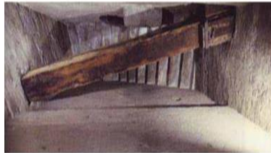
Slika 6. Presjek donjeg dijela kupole (lijevo) i prikaz drvenog sidrenog prstena (desno) [3]
