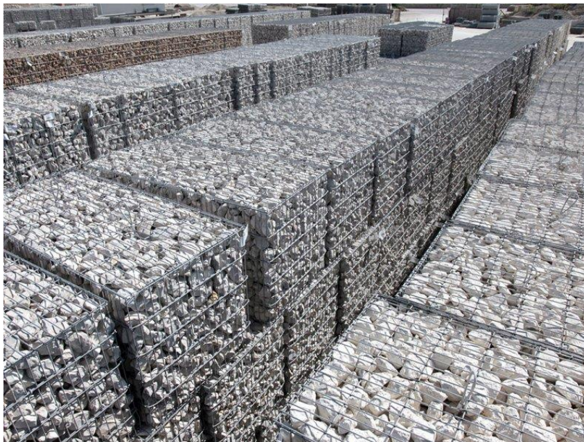
Slika 13. Gabionski propusni zidovi
