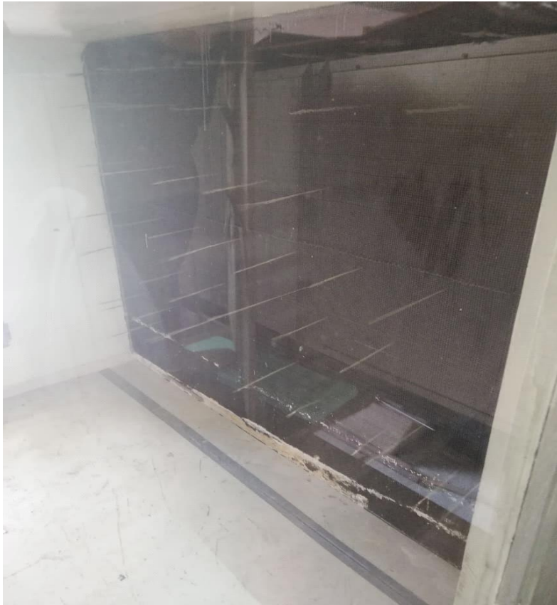
Slika 24. Mreža za ujednačavanje rasporeda brzina
