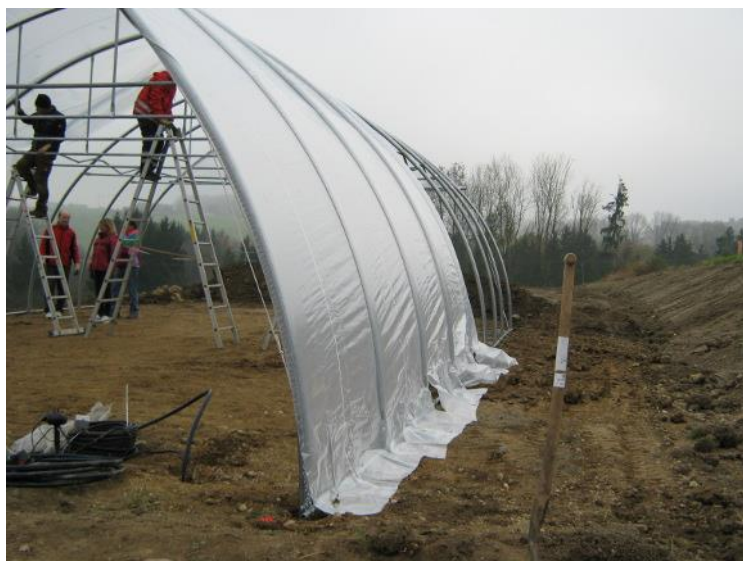
Slika 3. Folija kao materijal za pokrivanje
