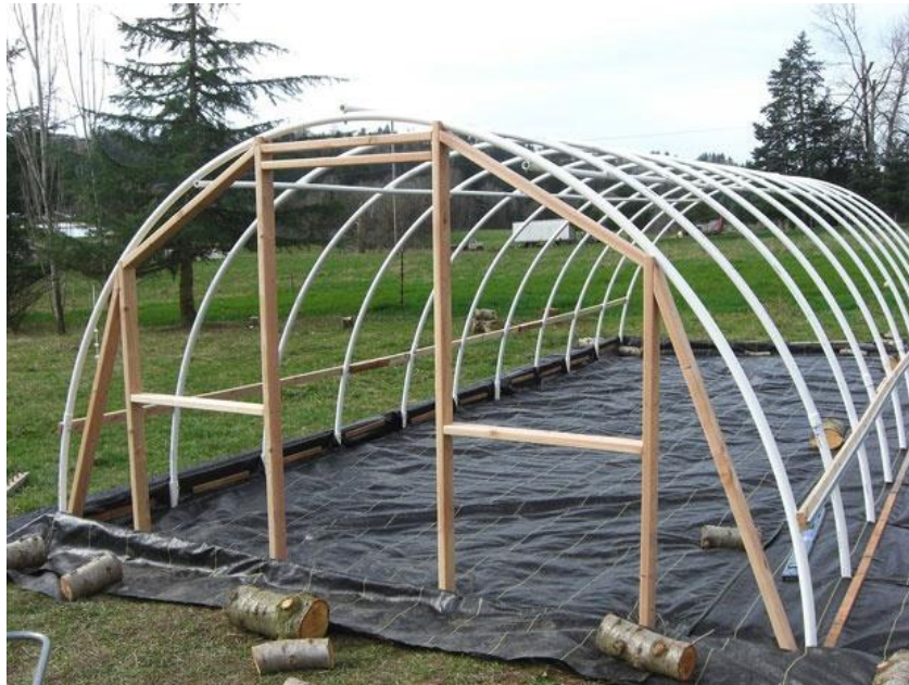
Slika 2. Montaža plastenika
