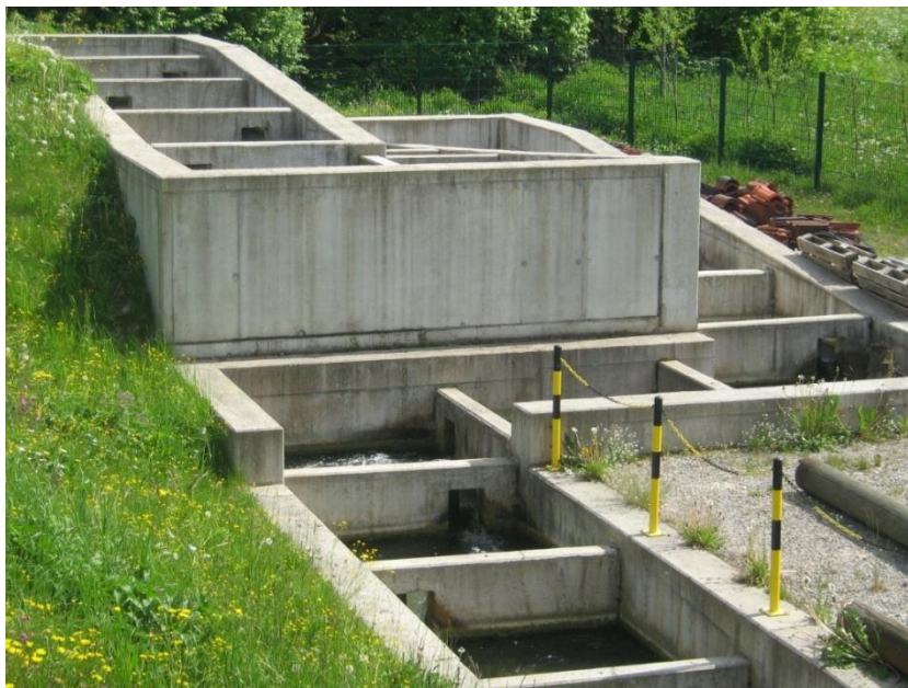
Slika 1.5 Riblja staza bazenskog tipa uz malu hidroelektranu u Njemačkoj
