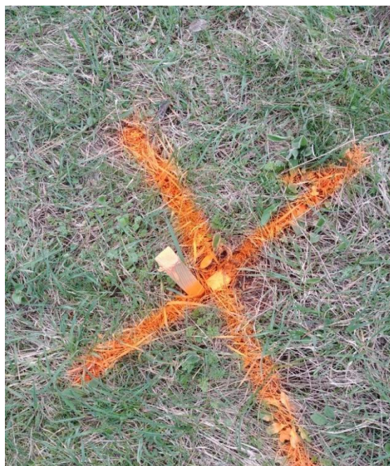
Slika 4. Dodatni kolčić za preciznu izmjeru
