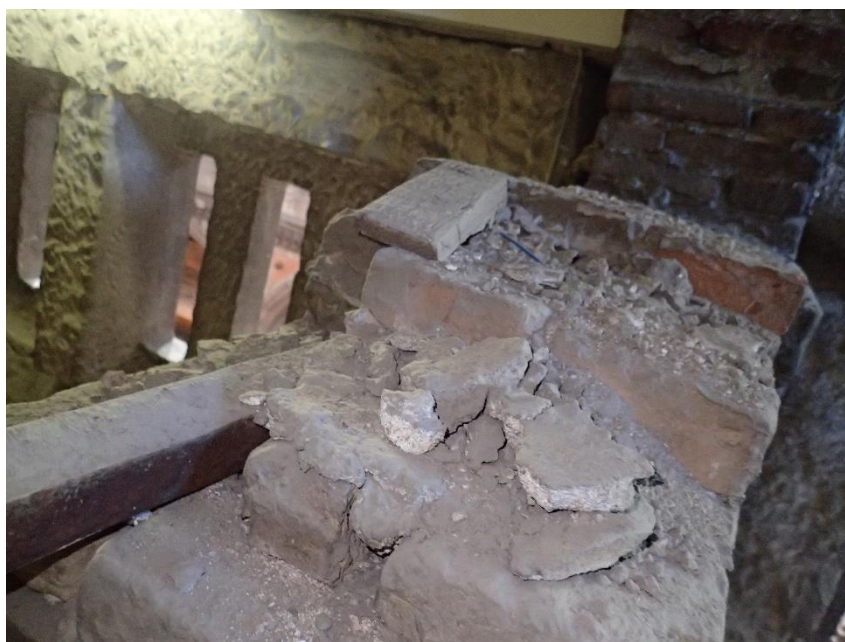
Slika 20 Sidrenje zatega u galeriji
