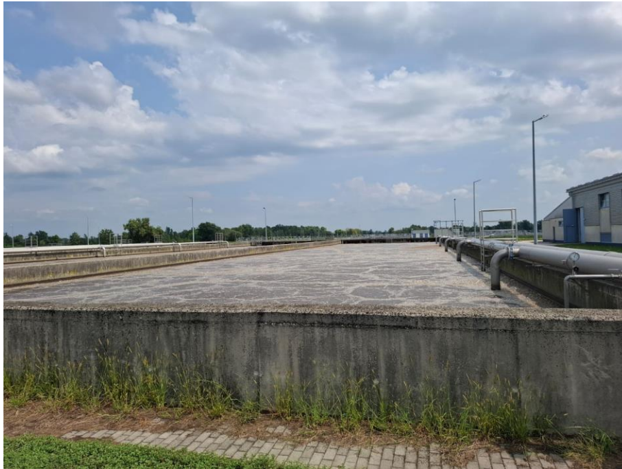
Slika 24. Sustav za dodavanje kisika i bakterija za razgradnju
