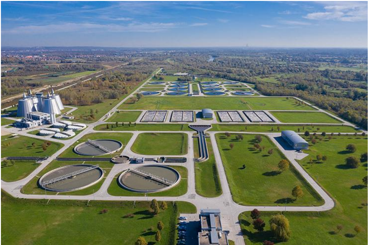
Slika 22. Centralni pročistač otpadnih voda grada Zagreba [21]
