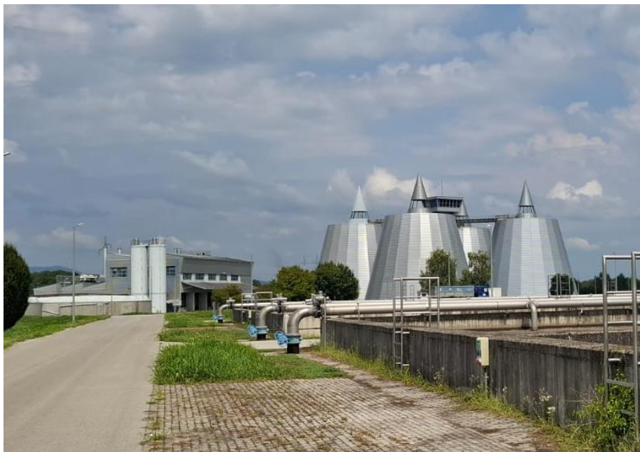
Slika 256. Digestori za bioplin
