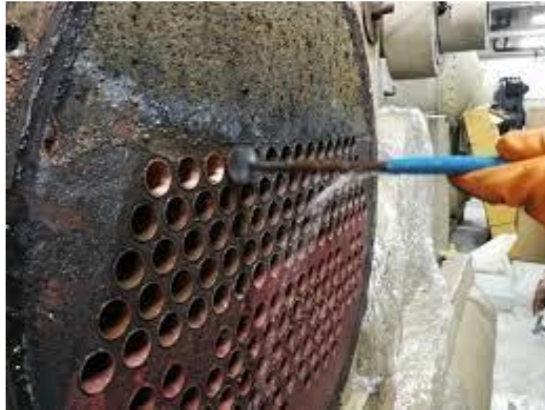
Slika 9. Biološko onečišćenje izmjenjivača topline [27]
