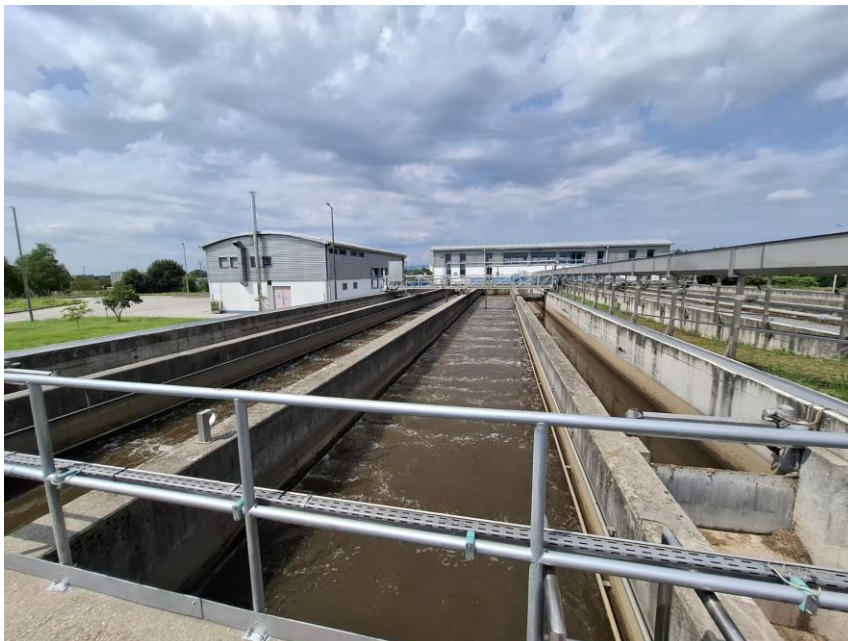
Slika 23. Mastolov i pjeskolov za izdvajanje masti i pijeska
