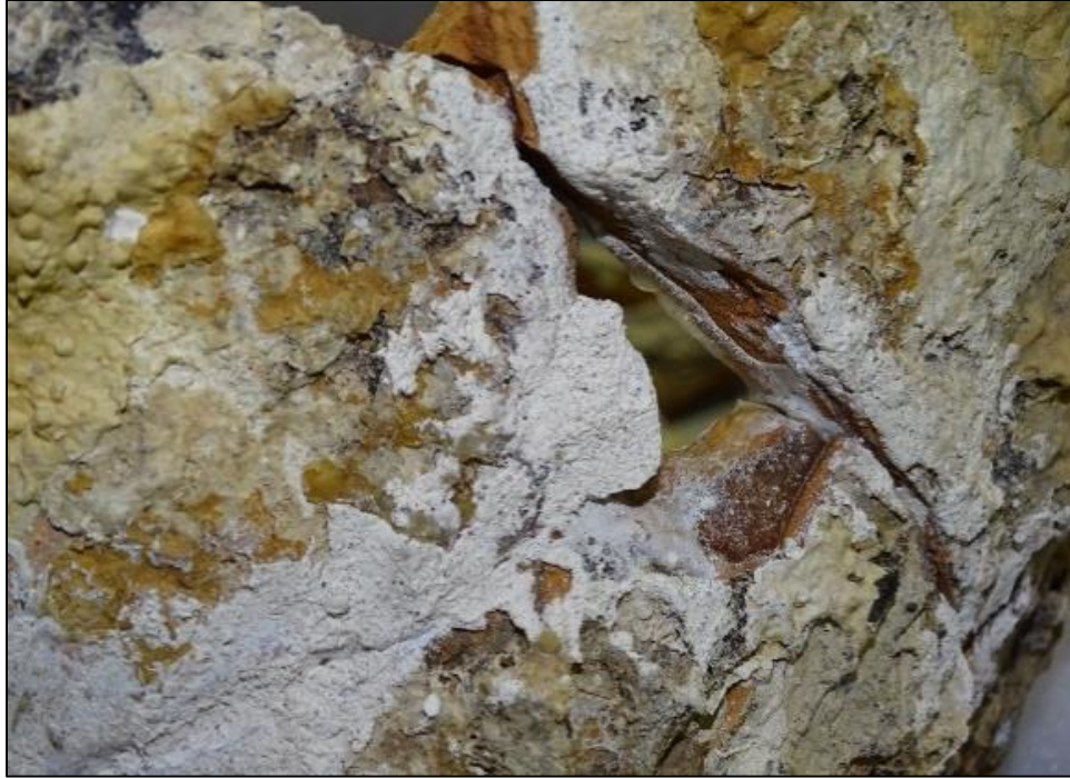
Slika 28: Prijašnje nadoknade nedostajućih dijelova bijelom žbukom, fragment br. 58 detalj (fotografirala: Sara knežević, siječanj 2023.)
