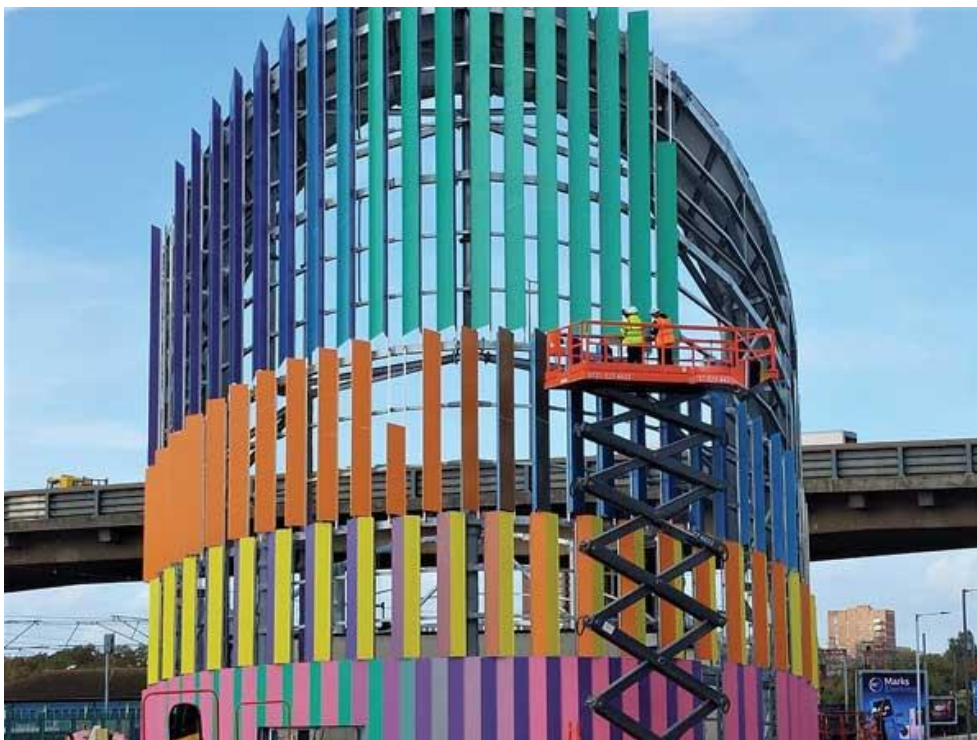
Slika 4.7 – Montaža fasadnih elemenata [26]
