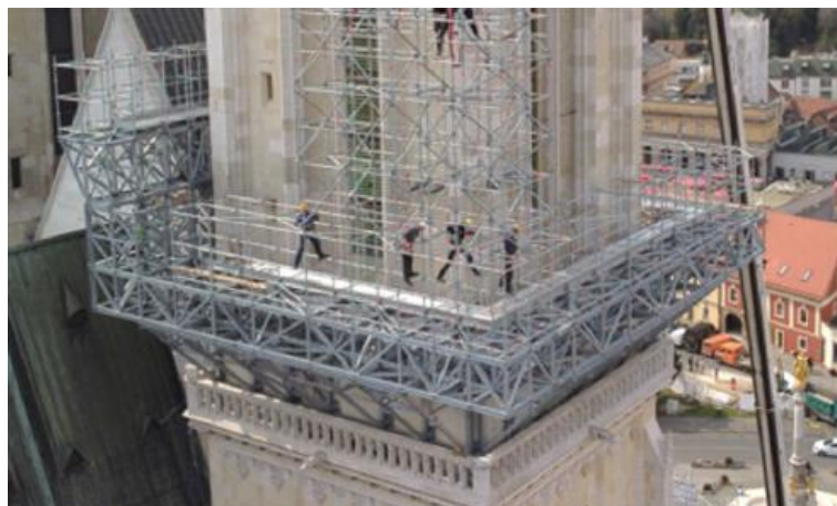
Slika 1.8 – Konstrukcija platforme toranjske skele Zagrebačke katedrale [18]
