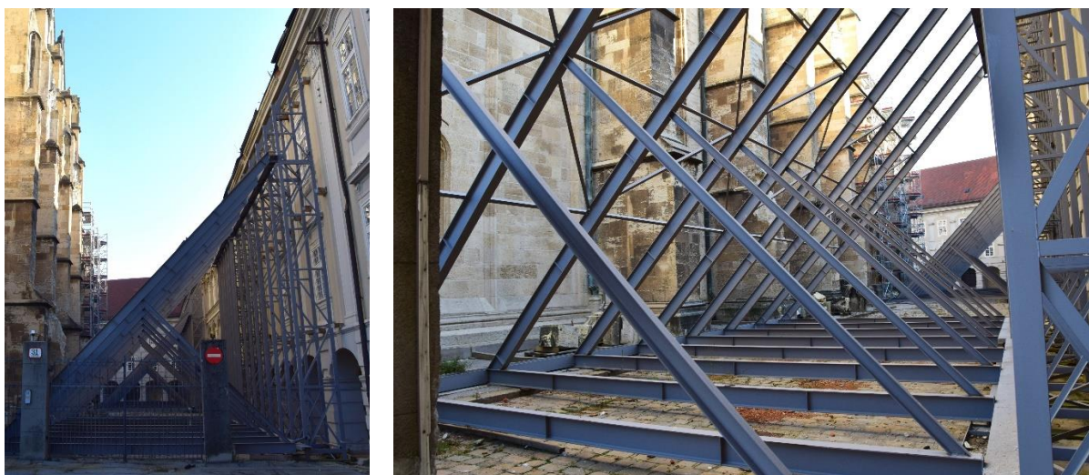
Slika 1.9 – Čelična konstrukcija za podupiranje Nadbiskupskog dvora na Kaptolu
