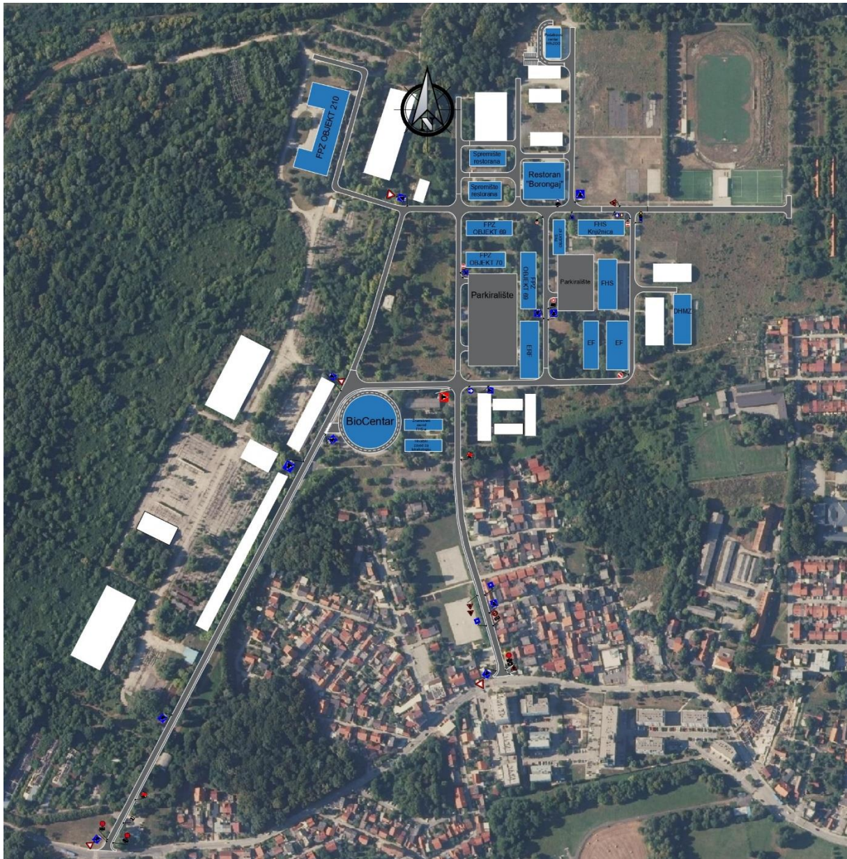
Slika 26. Postojeće stanje ZUK-a Borongaj
