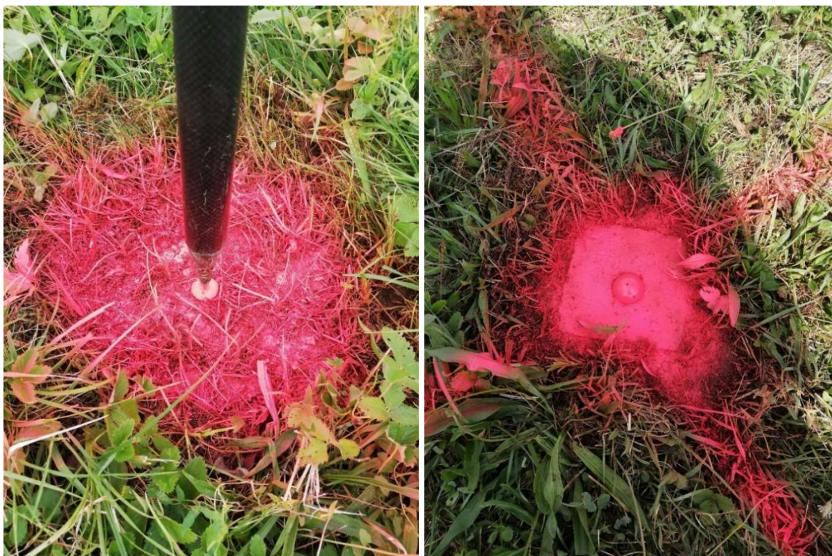
Slika 15. Stabilizacija dopunskih točaka geodetske mreže.
