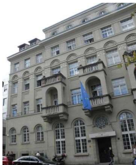
Slika 4. Istočno pročelje – orijentirano na Runjaninovu ulicu [6]
