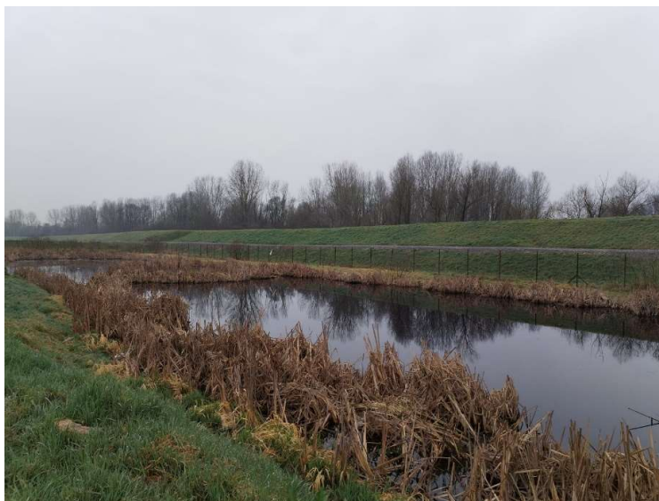
Slika 10. Retencijski bazen (4. bazen biljno biološkog pročišćača)
