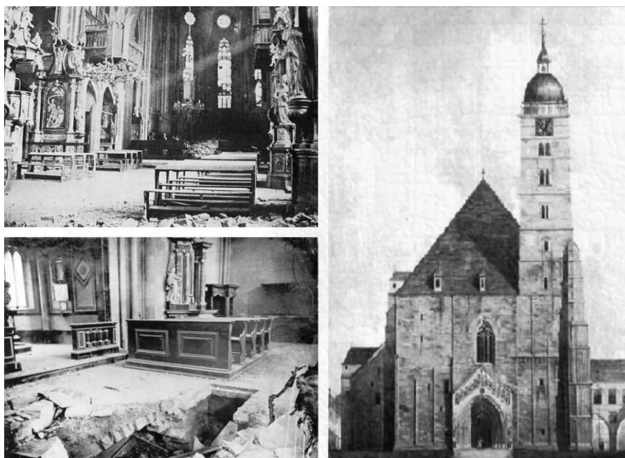
Slika 1.2 Oštećenja na katedrali nakon potresa 1880.[2]
