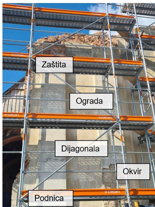
Slika 2.3 Dijelovi lagane cijevne skele
