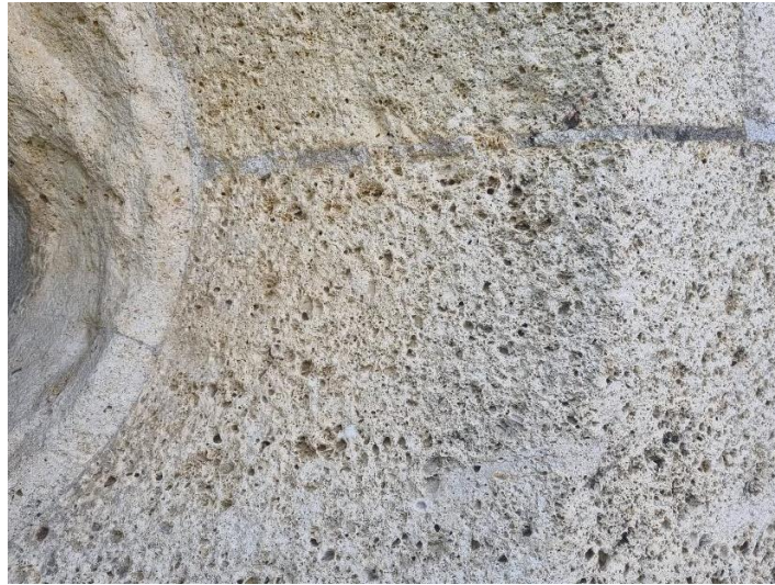
Slika 1.3 Prikaz porozne strukture oštećenog kamena na tornjevima
