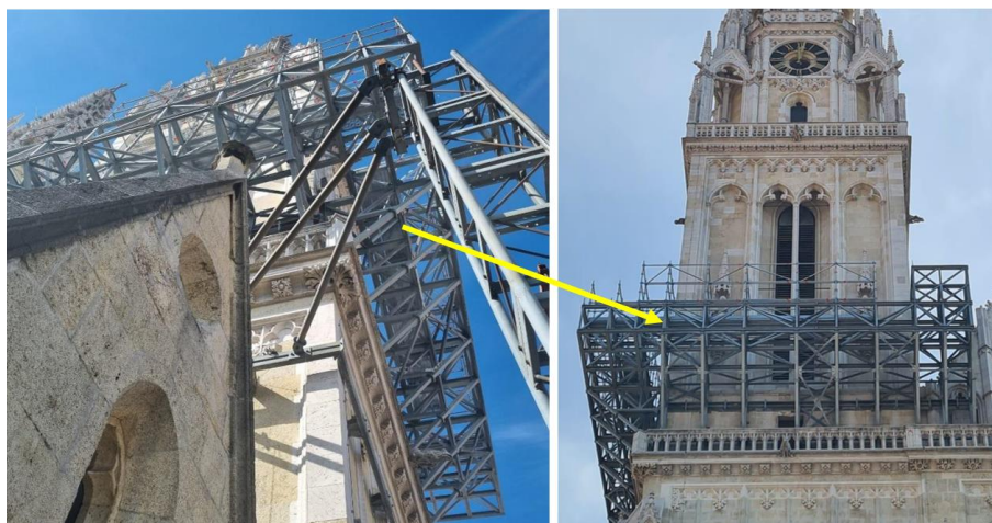
Slika 2.8 Platforma za oslanjanje skele na zapadnoj strani katedrale
