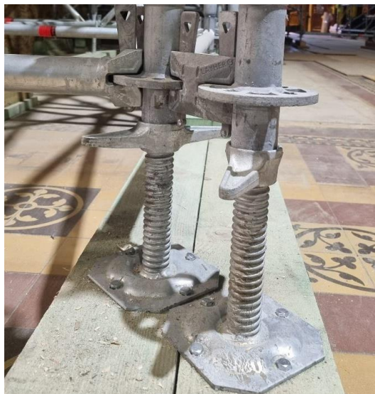
Slika 2.5 Stopa skele na drvenoj mosnici
