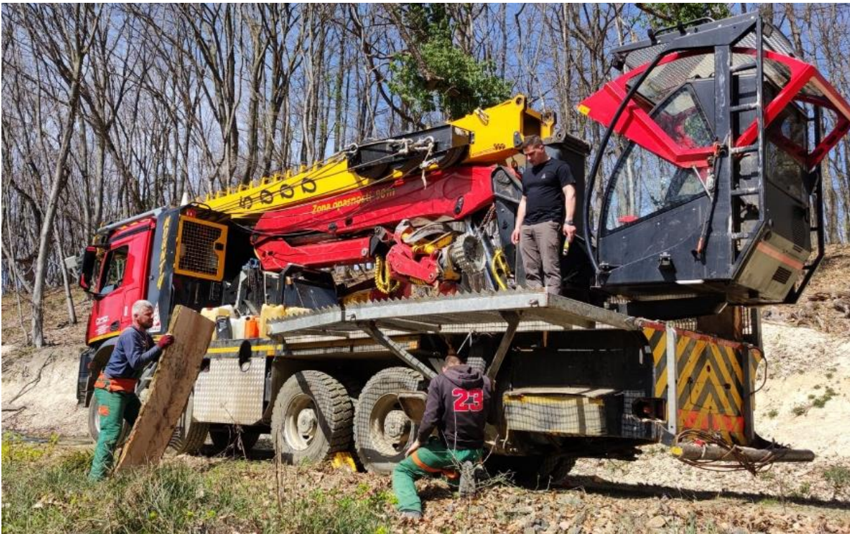
Slika 6. Postavljane kamiona na mjesto početka buduće trase
