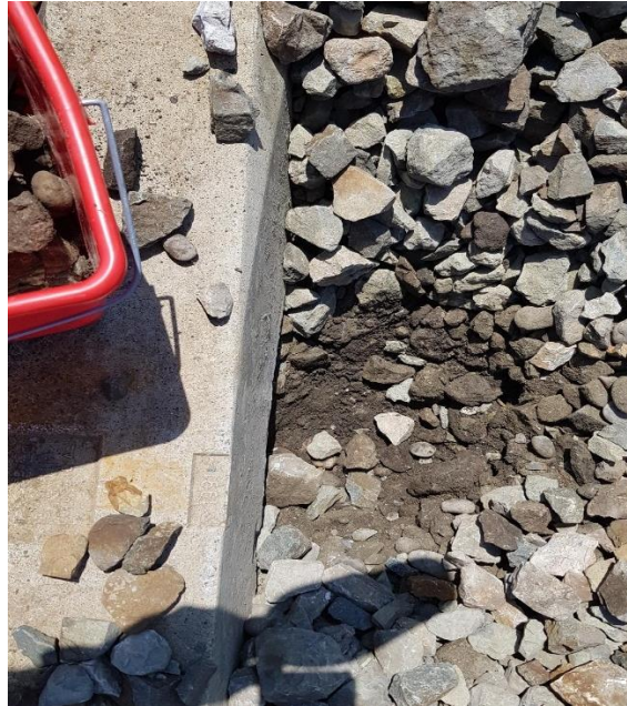
Slika 44. Prikaz dubine otkopavanja tucaničkog materijala
