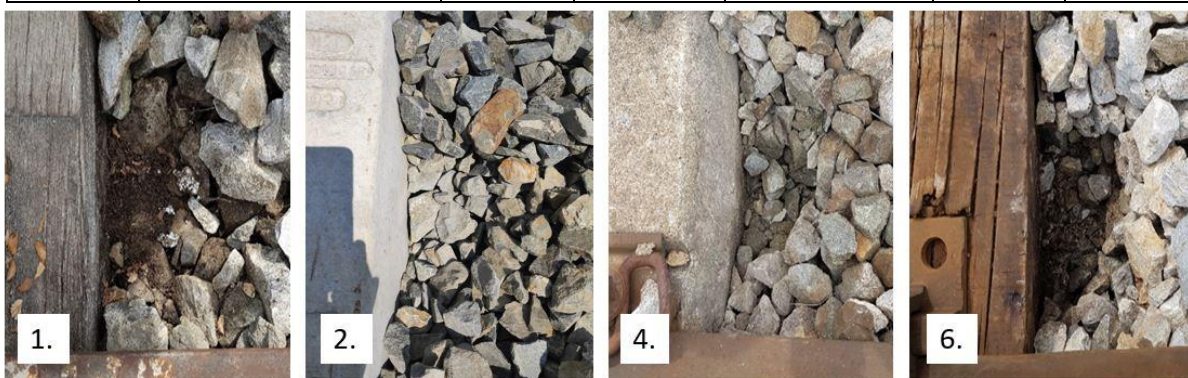
Slika 32. Prikaz otkopa i zablacenja promatranih kolosijeka
