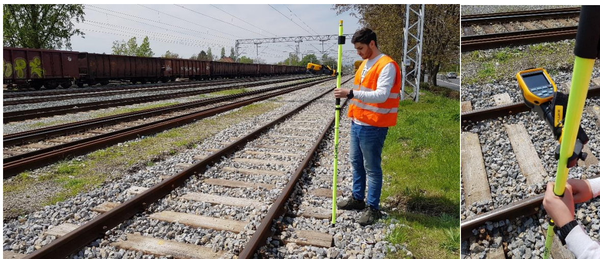
Slika 36. Provedba termografskog snimanja kolosijeka na kolodvoru Podsused
