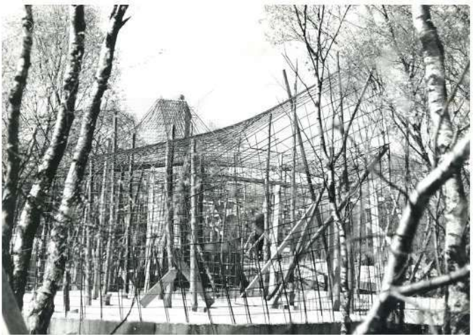
postavljanje armature i projektiranje na licu mjesta
