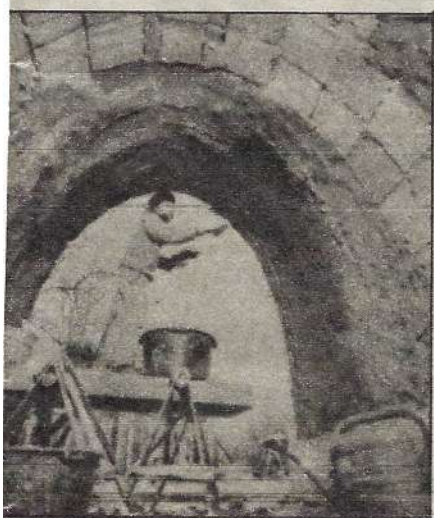
li sa žbukanjem nema problema. buka napravljena od ilovače zvrсно drži.
