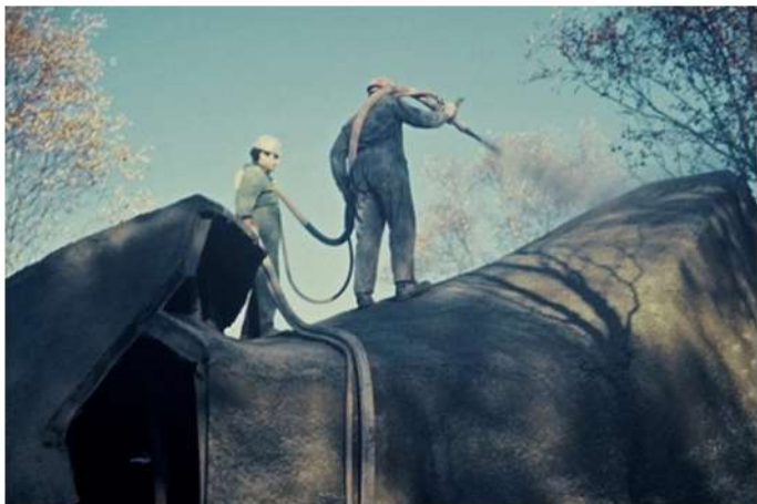
torkretiranje betona u organičnu formu
