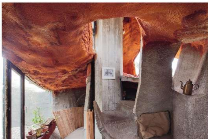
poliuretanska pjena kao termoizolacijski sloj iznutra
