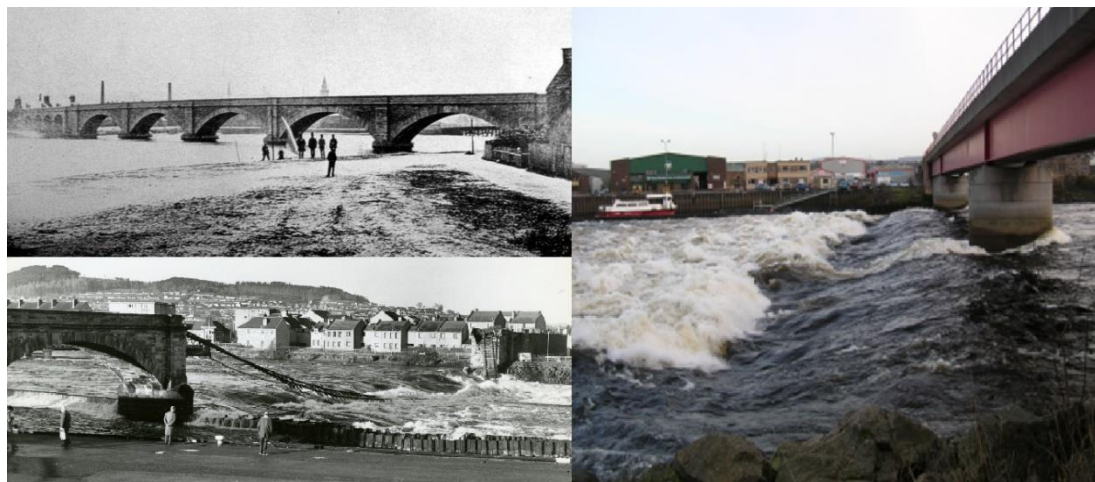
Slika 3. Prikaz željezničkog mosta preko rijeke Ness u Ivernessu prije i nakon urušavanja (lijevo) [11, 12] i izvedbu rješenja novog željezničkog mosta(desno) [13]
