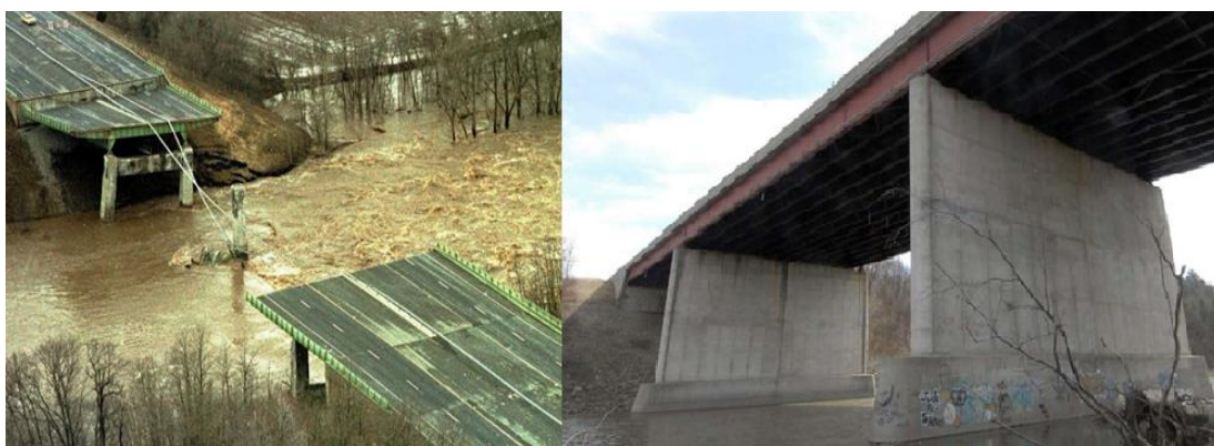
Slika 2. Prikaz mosta Schoharie Creek nakon havarije i nakon rekonstrukcije [10]
