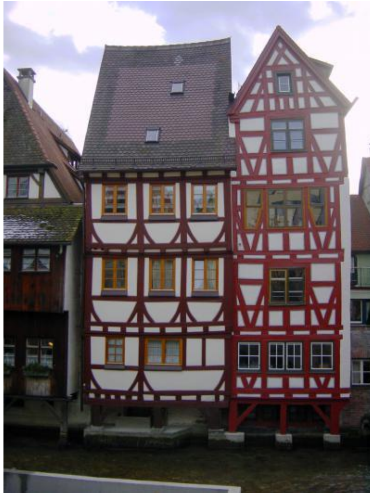
Slika 1.4 Drvena kuća-kanatni sustav
