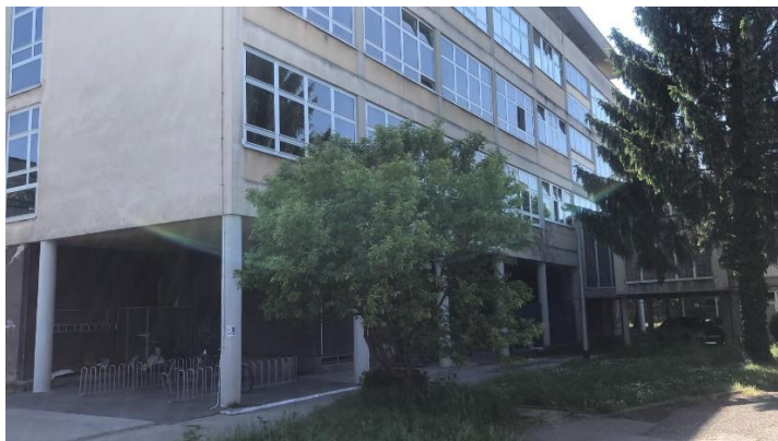
Slika 13. Postojeće stanje sjevero-istočnog pročelja visokog prizemlja
