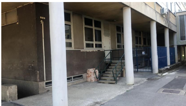
Slika 14. Postojeće stanje sjevero-istočnog pročelja niskog prizemlja
