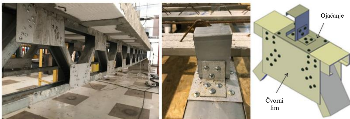
Slika 1.4. Detalji izvođenja međukatne konstrukcije [11]
