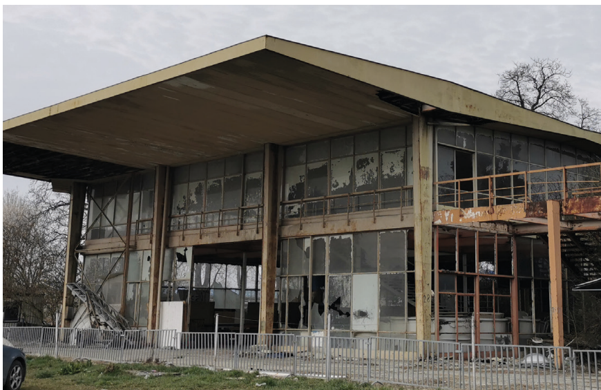
Paviljon tvornice "Đuro Đaković" (paviljon 28) danas
