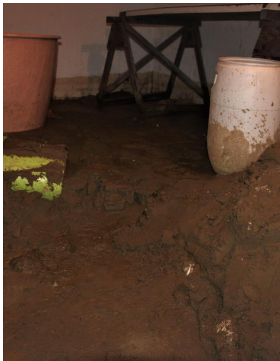
Slika 4. Oštećenja građevinskih struktura uzrokovanih likvefakcijom: a) slom nasipa; b) slom prometnice u Novoj Drenčini; c) oštećenje podrumskog zida kao posljedica likvefakcije
