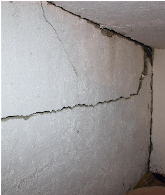
Slika 4. Oštećenja građevinskih struktura uzrokovanih likvefakcijom: a) slom nasipa; b) slom prometnice u Novoj Drenčini; c) oštećenje podrumskog zida kao posljedica likvefakcije
